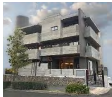
インクローバー外観↑
